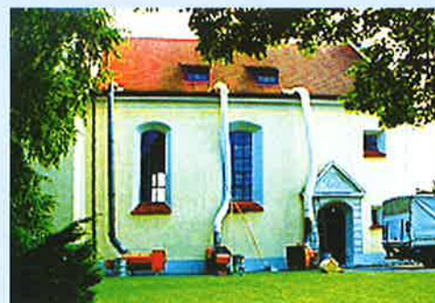
6.) Tratamento térmico com umidade controlada do madeiramento infestado de uma igreja. Este método pode ser aplicado em caixões perdidos, armário na área doméstica e patrimônio cultural.
